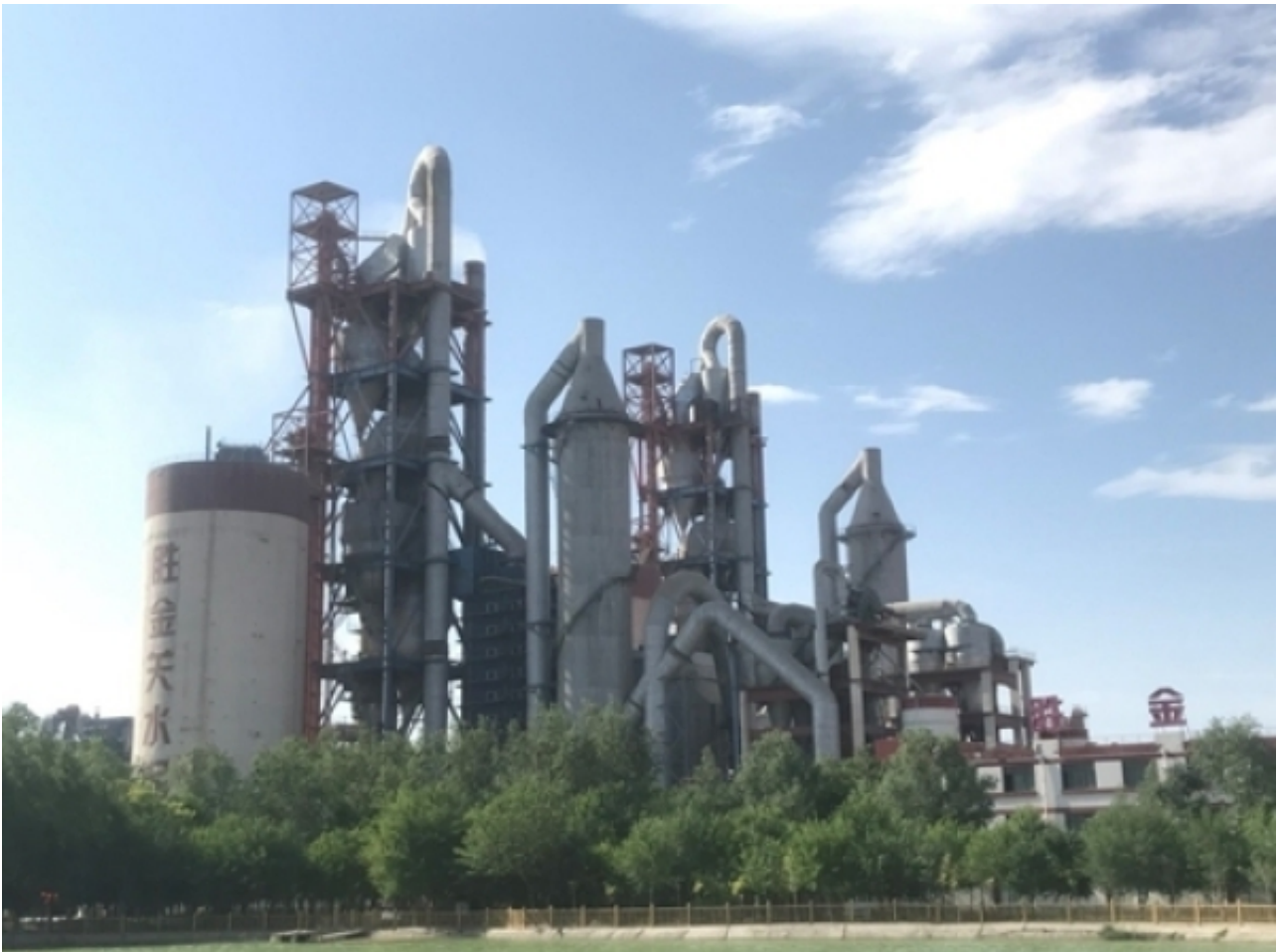
2500吨每天水泥窑炉低 \text{NO}_x 关键技术示范工程
