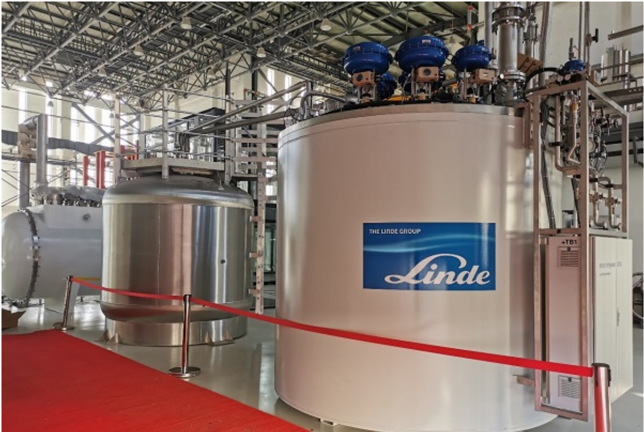
氮制冷机冷箱和杜瓦
