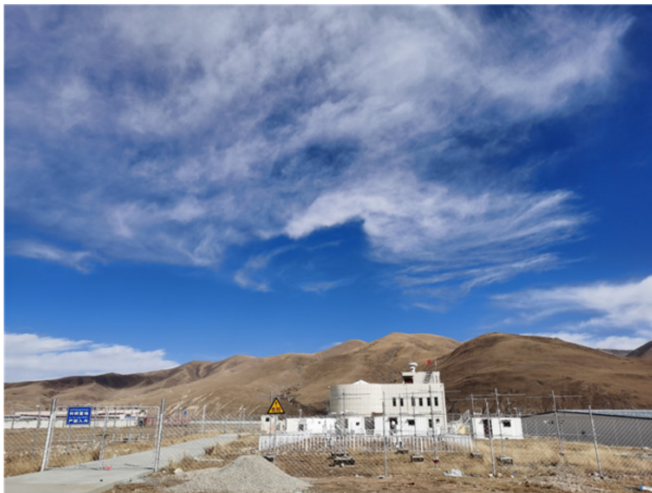
图5.西藏羊八井APSOS系统全景
