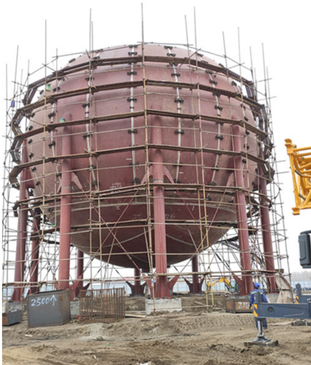
100MW先进压缩空气示范项目储热子系统安装
