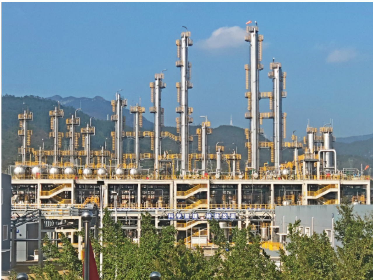
十万吨级离子液体催化CO 2 合成碳酸酯工业装置
