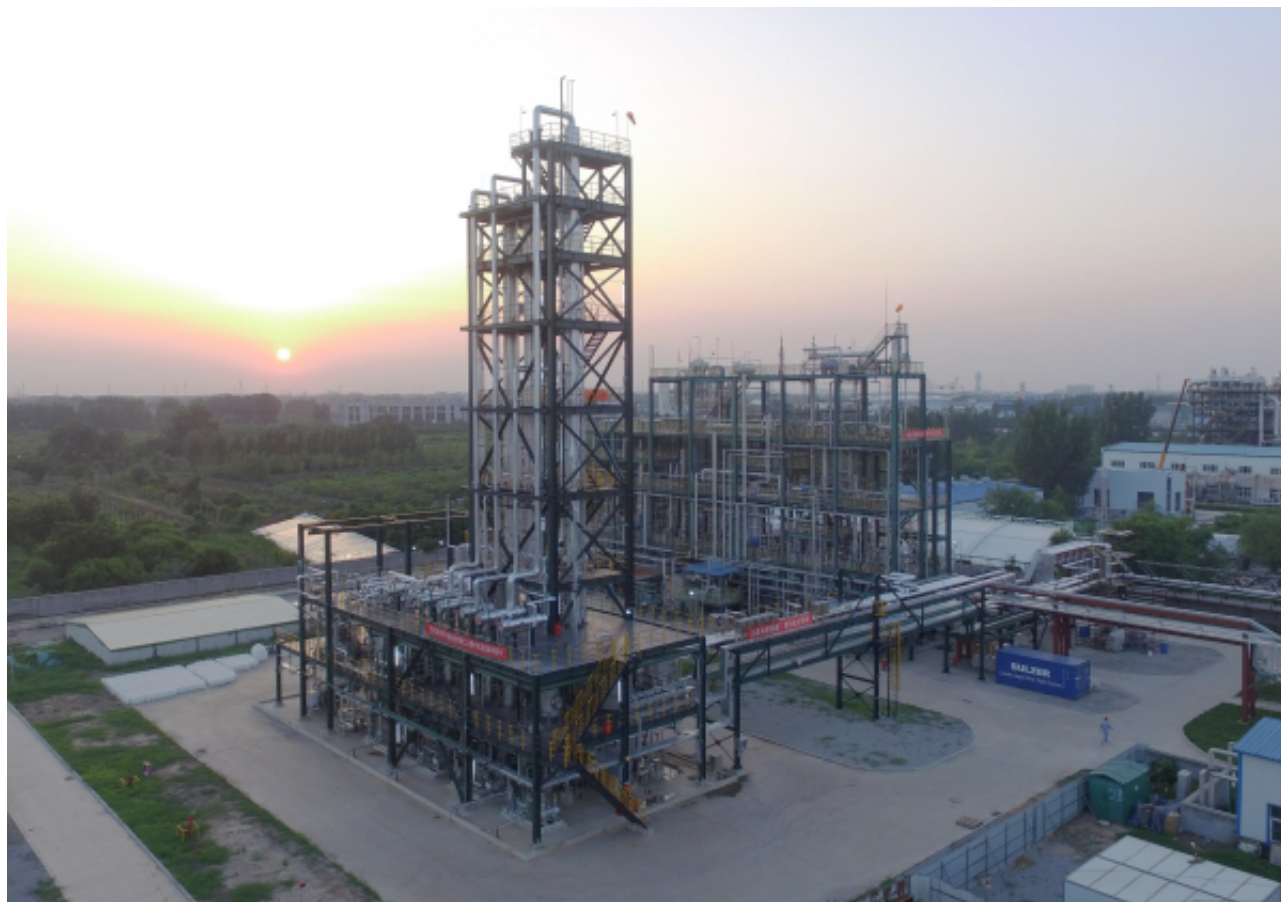
千吨级生物质催化转化制乙二醇装置
