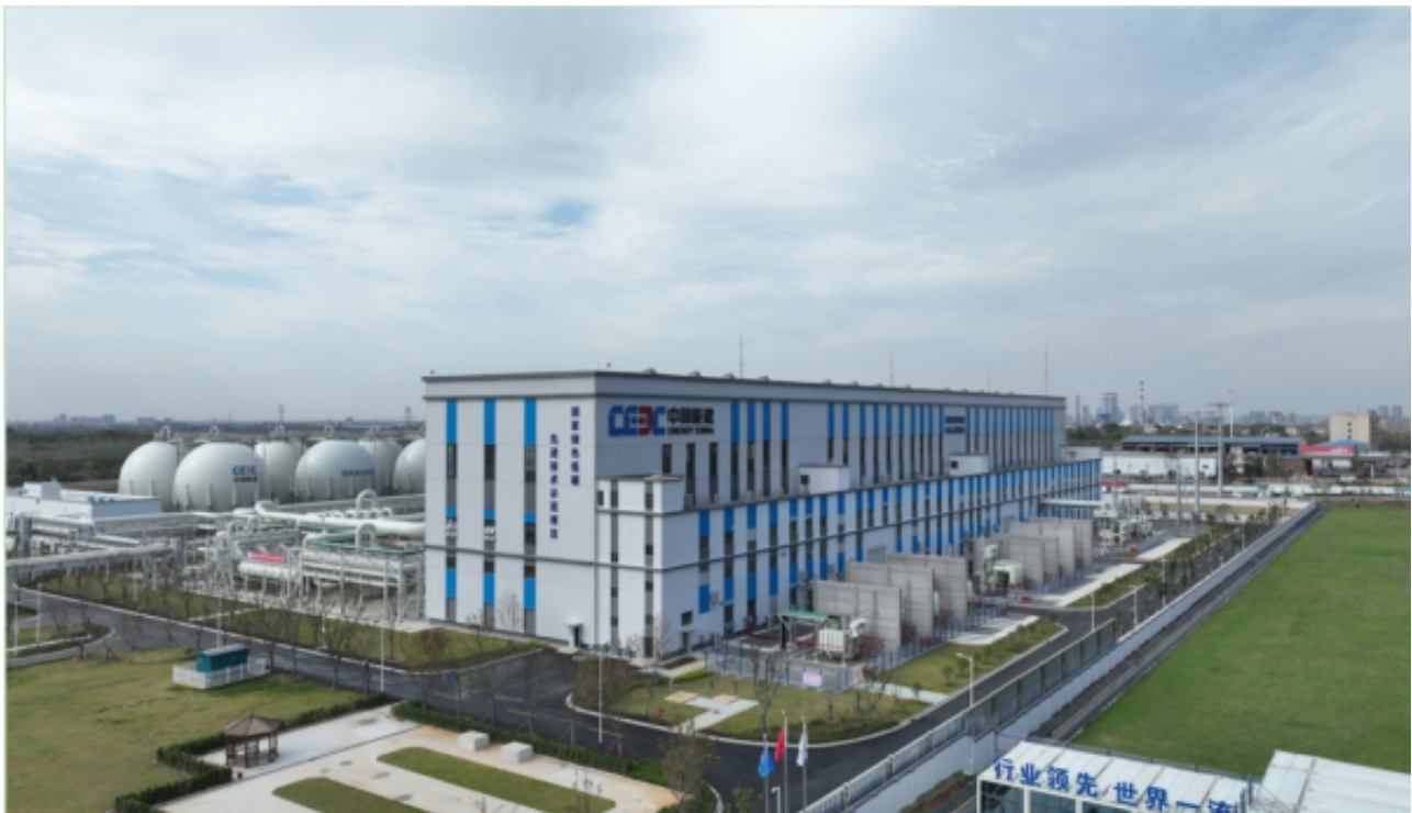
湖北应城300MW压缩空气储能电站
