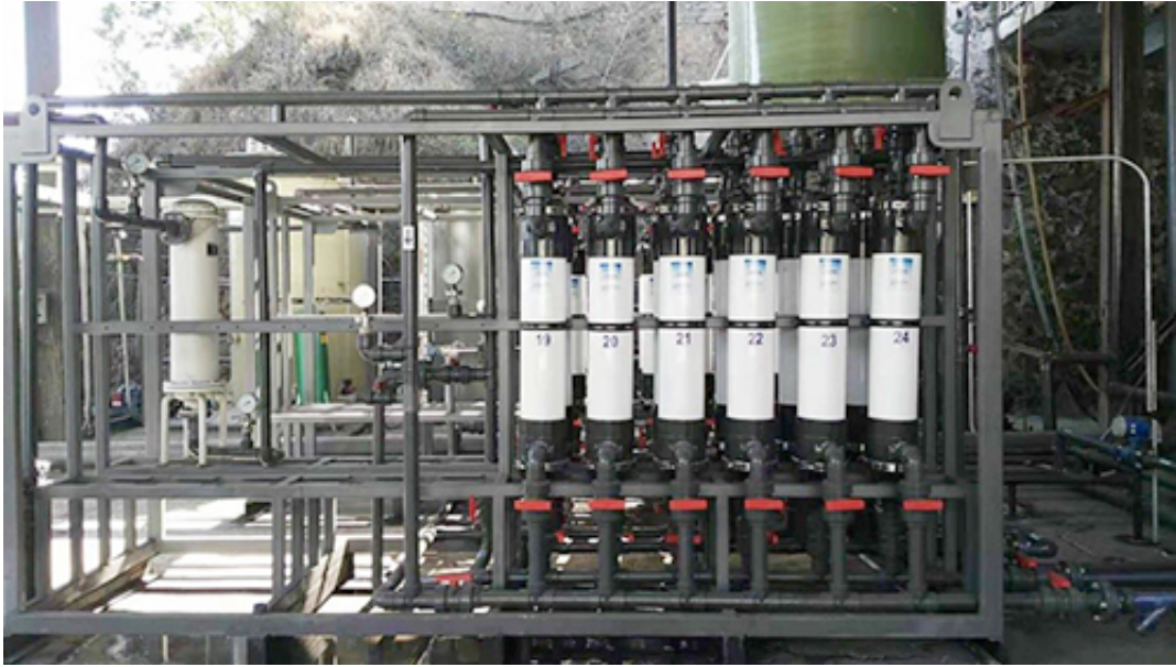
PTFE膜技术脱氨项目现场
