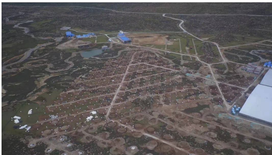
图3. 地面阵列鸟瞰图，缪子探测器位于锥形土堆下方，白色方块为电磁粒子探测器。
