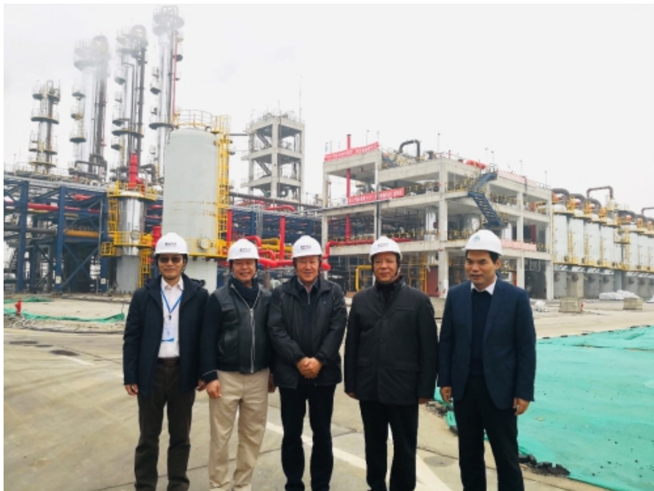
德州实华“姜钟法”40万吨聚氯乙烯无汞新工艺/年装置
