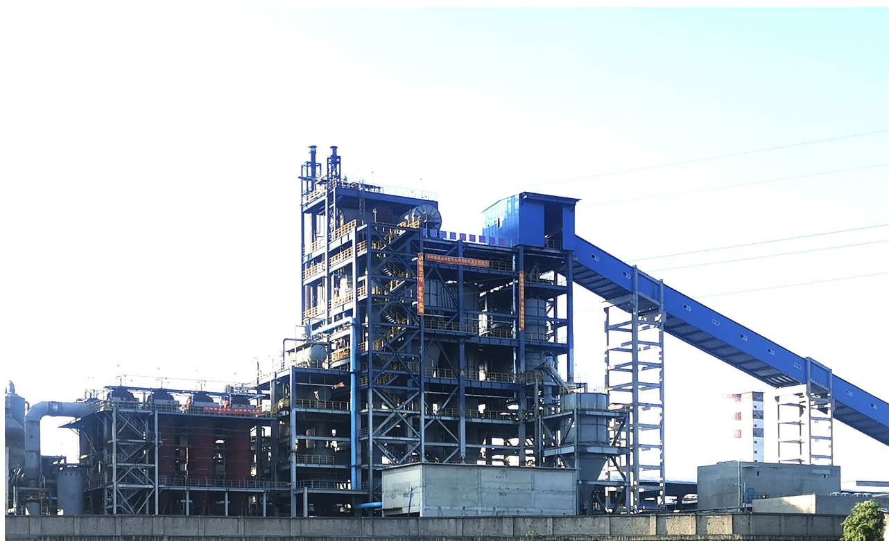
贵州宏盛化工30万吨合成氨系统造气工段升级改造项目现场
